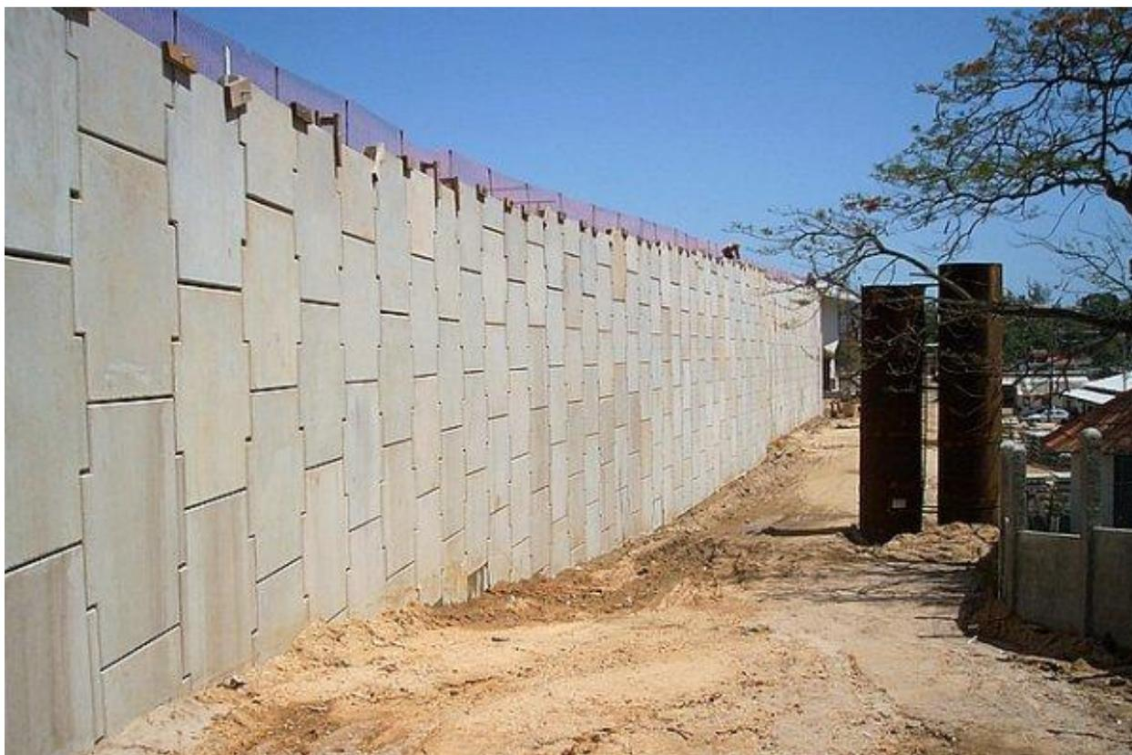
**Foto 4.1.2-3:** Vista de um modelo de aterro utilizando o método de terra armada (Fonte: Terra Armada Ltda.).
