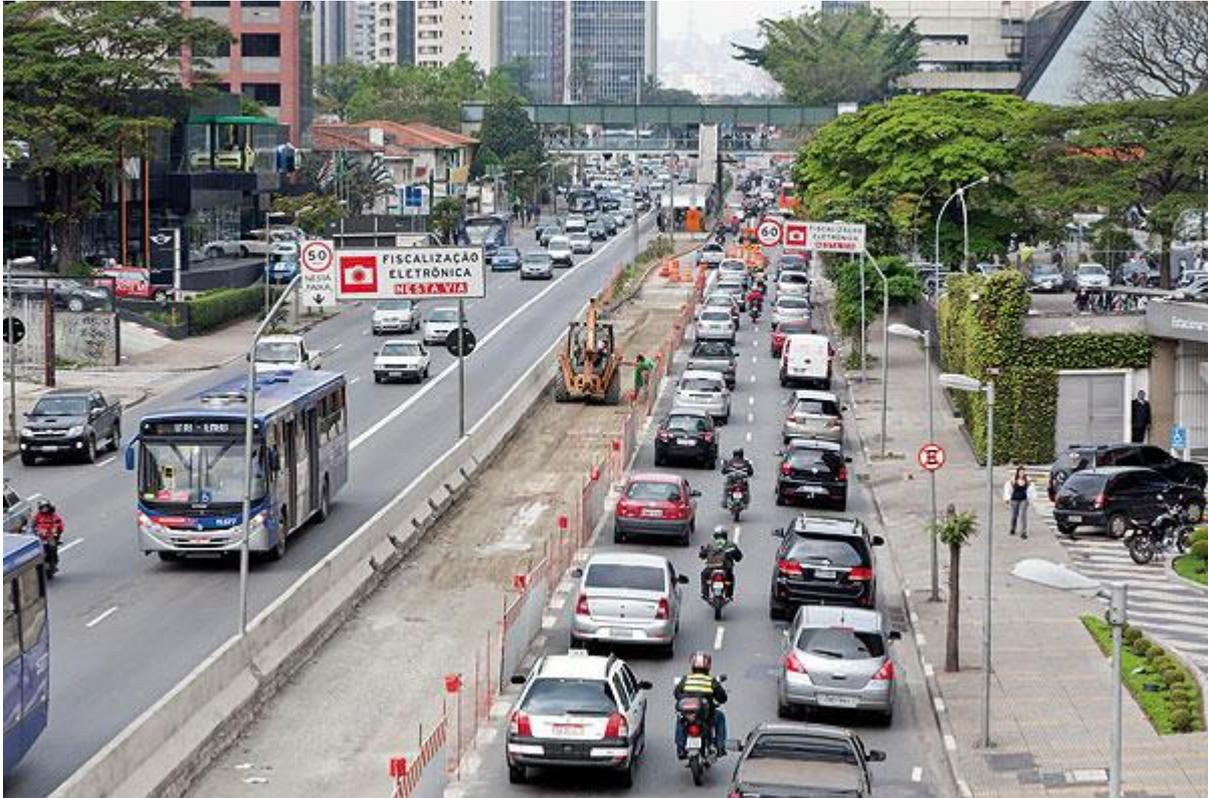
**Foto 4.1.2-1:** Vista do Corredor Campo Limpo-Rebouças-Centro tendo seu pavimento trocado por concreto. Note que a intervenção se restringe a uma faixa de rolamento.
