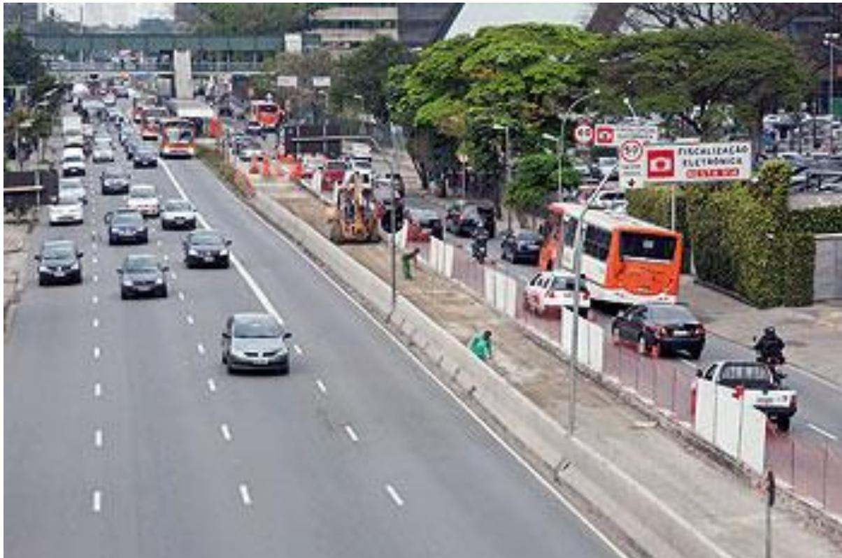
**Foto 4.1.2-2:** Outra vista do Corredor Campo Limpo-Rebouças-Centro tendo seu pavimento trocado por concreto, onde a intervenção se restringe a uma faixa de rolamento.
