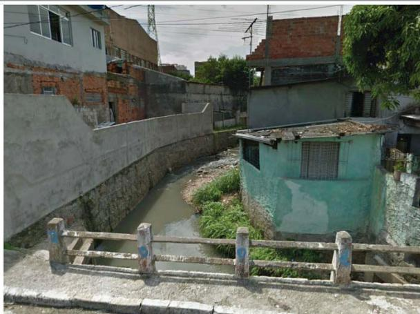
**Foto 8.2.1.6-31:** Notar a presença de lixo e entulho dentro do canal do córrego.
