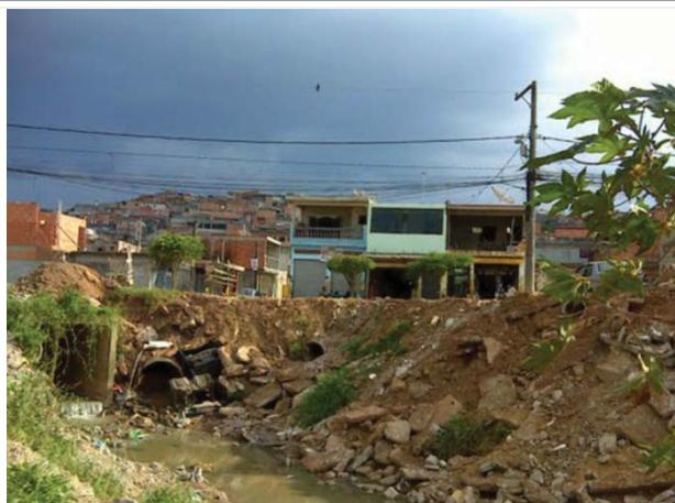
**Foto 8.2.1.6-9:** Detalhe de trecho onde se observa canalização a céu aberto e canalização fechada. Notar a grande quantidade de lixo e entulho nas margens do córrego e a quase ausência de mata ciliar.
