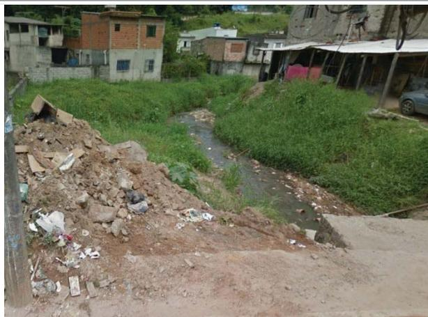
**Foto 8.2.1.6-17:** Detalhe de trecho onde se observa canalização a céu aberto. Notar a grande quantidade de lixo e entulho nas margens do córrego e a quase ausência de mata ciliar.
