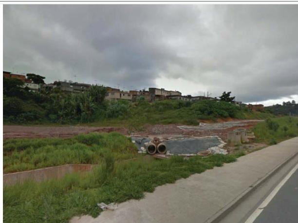
**Foto 8.2.1.6-13:** Observa-se parte do córrego com canalização a céu aberto e canalização fechada, linear a Avenida Jacú Pêssego.
