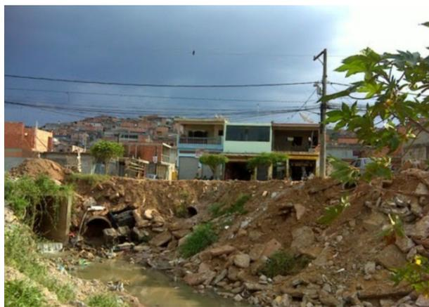
**Foto 4-1:** Detalhe de trecho do córrego Caguaçu, afluente do córrego Aricanduva, onde se observa canalização a céu aberto e canalização fechada. Notar a grande quantidade de lixo e entulho nas margens do córrego e a quase ausência de mata ciliar.
